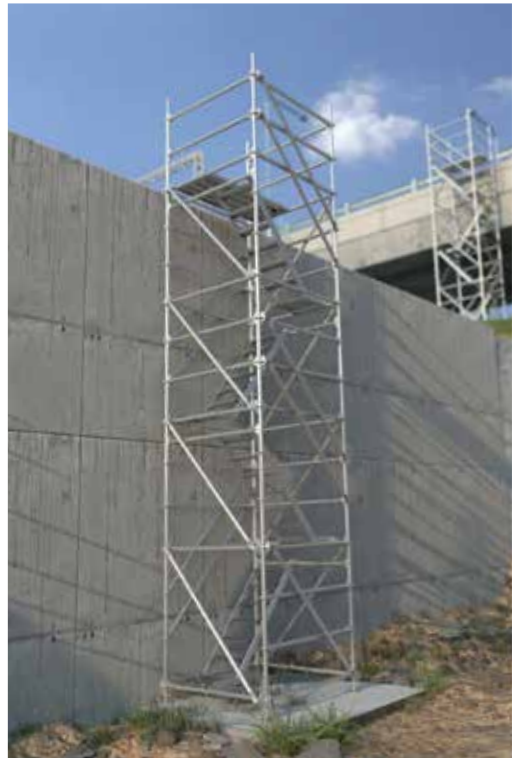
Accès au chantier tour d'escalier
