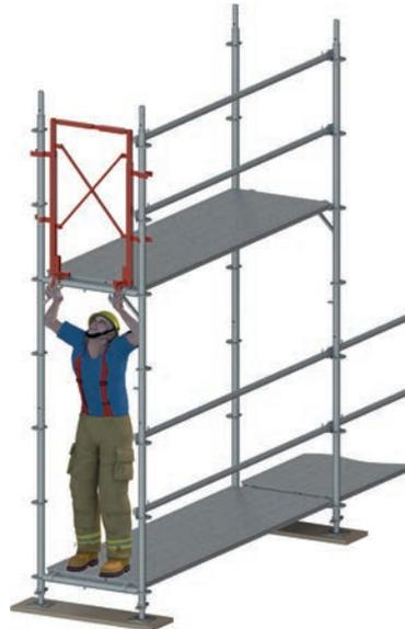
Figure 18 : Positionnement final de l'extrémité frontale et sécurité.
