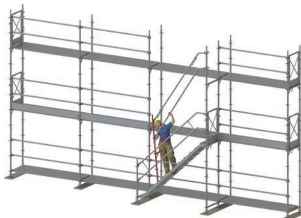
Figure 41 : Montage des mains courantes d'escalier sur cadre en T.
