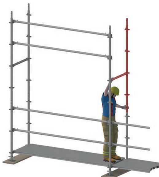
Figure 23 : Montage du second montant vertical et du rail.
